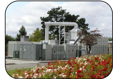
1.4 MW On-site CHP
